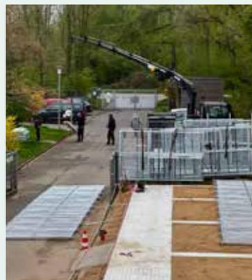
**Baubeginn Voliere:** Links im Bild sind die Metallwände für den neuen Putzgang zu sehen. Dieser ermöglicht es künftig, jede Einzelvoliere separat zu betreten – ein wichtiger Schutz vor der Übertragung von Keimen, den wir bei der Planung besonders berücksichtigt haben.
